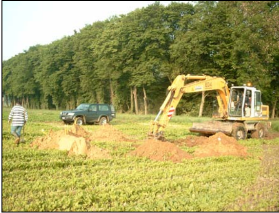
Photo 1 : Creusement de la fosse en séparant les horizons
