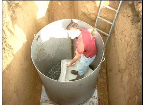
Photo 2 : Lysimètre posé dans la fosse, fond avec graviers et géotextile
