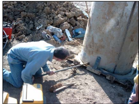
Photo 10 : Demi-ceinture pour le joint de soudure ; pré-trous pour les tuyaux drainant
