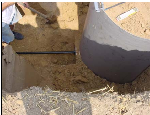
Photo 5 : Raccord au tuyau d'évacuation
