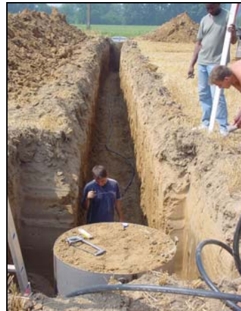
Photo 4 : Lysimètre rempli, tranchée jusqu'à la chambre de visite
