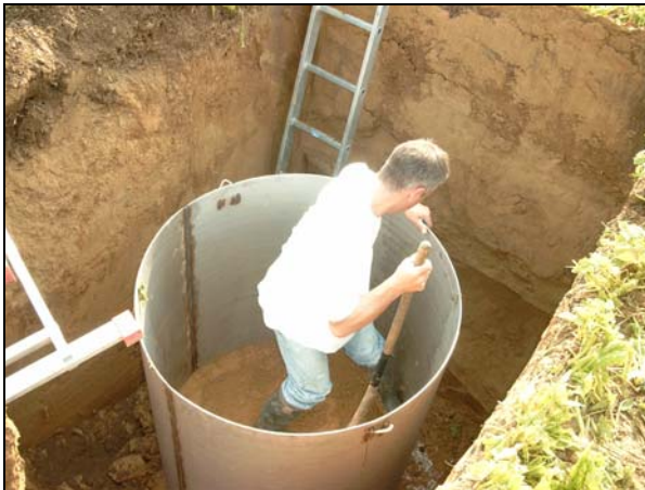
Photo 3 : Remplissage manuel couche par couche
