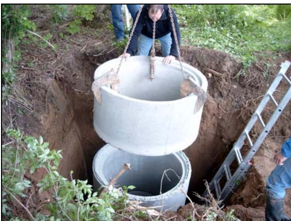
Photo 17 : Empilage des anneaux à la grue
