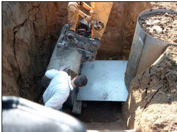
Photo 9 : Dégagement du cylindre, enfoncement de la plaque de fond horizontalement à la grue
