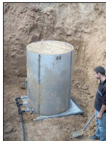
Photo 12 : Lysimètre replacé à la profondeur -50cm ; raccord au tuyau d'évacuation
