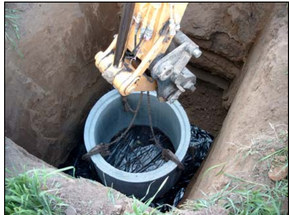
Photo 14 : Fond bâché, anneau de base avec armatures
