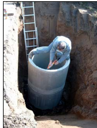
Photo 16 : Empilage des anneaux, joint d'étanchéité
