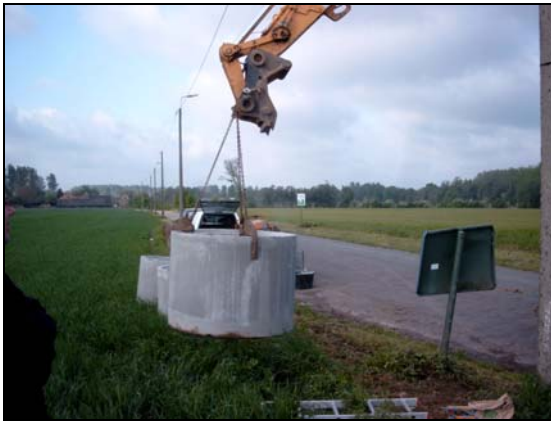
Photo 13 : Installation à la grue
