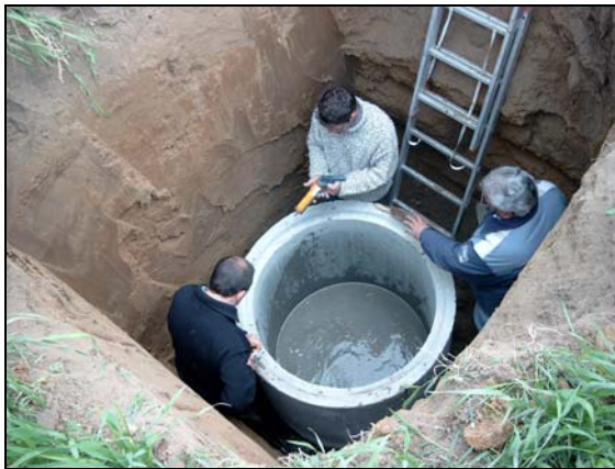
Photo 15 : Mortier de fond, pose de joint silicone
