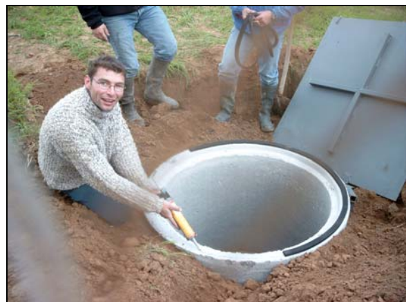
Photo 18 : Couvercle renforcé, joint de mousse pour l'étanchéité à la fermeture
