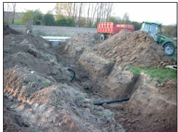
Photo 6 : Rebouchage du chantier avec réparation de drains
